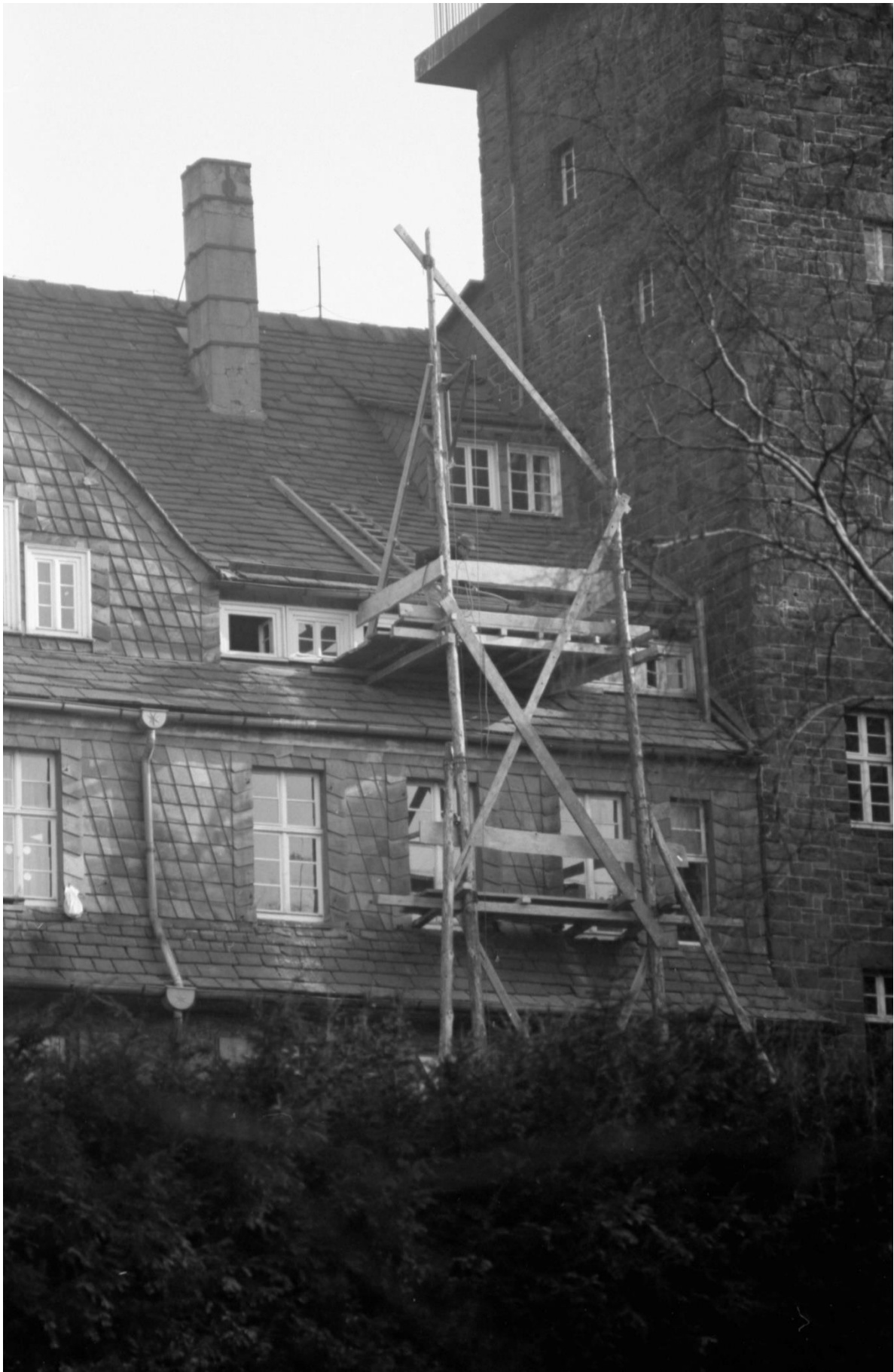
...350; Baugerüst am Oberhaus, da wird der Waschraum umgebaut.
